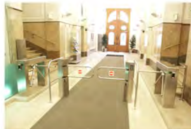
_tomelli per controllo varchi
